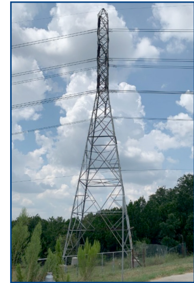
Estructura de Celosía
