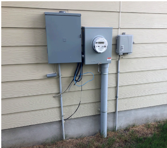
Conexión del Medidor Subterránea Típica
